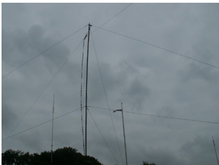
Bovenzijde mast met een zelfbouw G5RV antenne.
