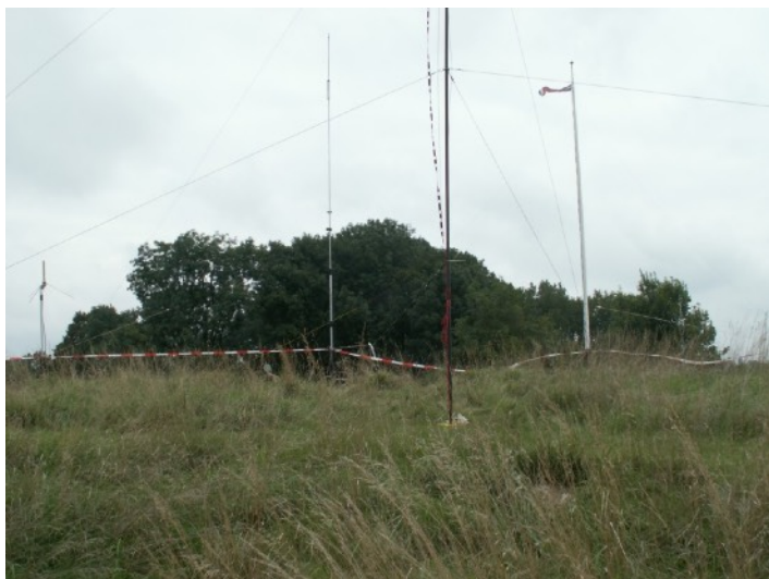
De onderzijde mast met tuidraden
