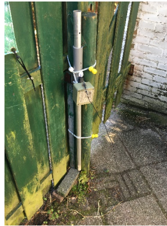
De voet van de mast aan de schutting
